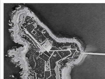
1056 Última imagen aérea del palacio de Monte Real tomada el 24.07.1956 .
