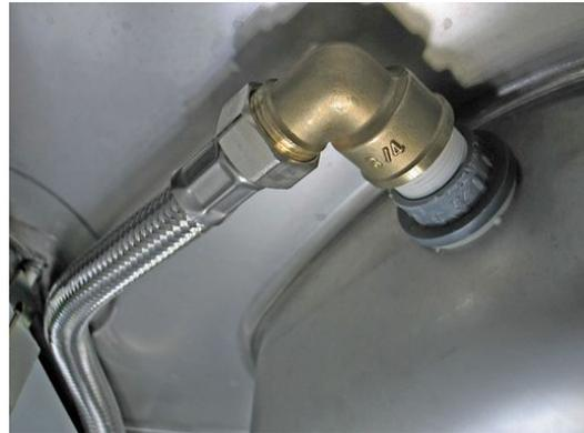
se dirija hacia la parte superior y trasera del depósito de aguas residuales, haciendo una leve **vaguada sifónica** que evite el retroceso de olores,
