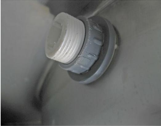
Aunque no es imprescindible porque ya llevará junta de goma en el fondo la pieza que se le va a acoplar, aplicamos cinta o hilo de **teflón** a las dos primeras vueltas de la rosca y empalmamos el **codo**.
