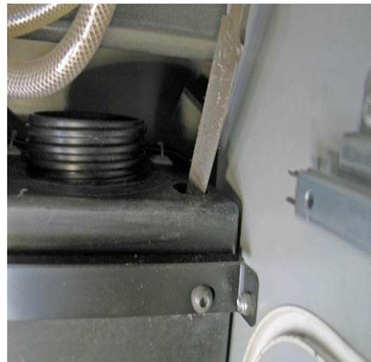
Con extrema precaución, por el tapón de registro abierto, **metemos el racor** de forma que la **rosca asome hacia arriba**. Y lo aseguramos con la tuerca. Igualmente deben quedar las gomas inmediatamente encima y debajo de la pared.
