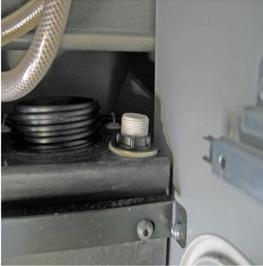
Y en esa rosca es donde termina el **extremo opuesto del latiguillo**, que enroscamos con la misma llave del **29**.
