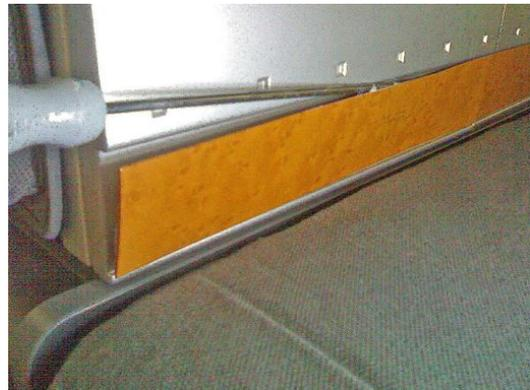
Se trata de un **adhesivo de doble cara** que las mantiene fijadas a los muebles sin que casi deje residuo.
