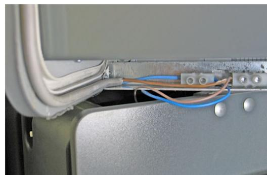
Ahora ya sólo queda tender la línea eléctrica mediante un cable del color más mimético posible por toda la trasera del mueble giratorio y junto al carril por el que se desplaza la persiana. Lo fijaremos con cinta transparente adhesiva de doble cara hasta la zona de la balda superior.
