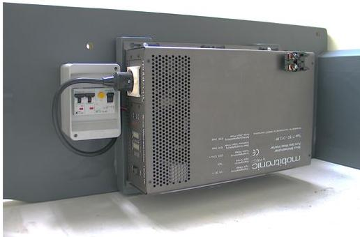
y enchufamos en él el cable de acometida que entra en el cuadro de protección y dejamos previsto en uno de los interruptores de la cocina un cable para poder encender y apagar el inversor cómodamente sin necesidad de acceder al interior del maletero.
