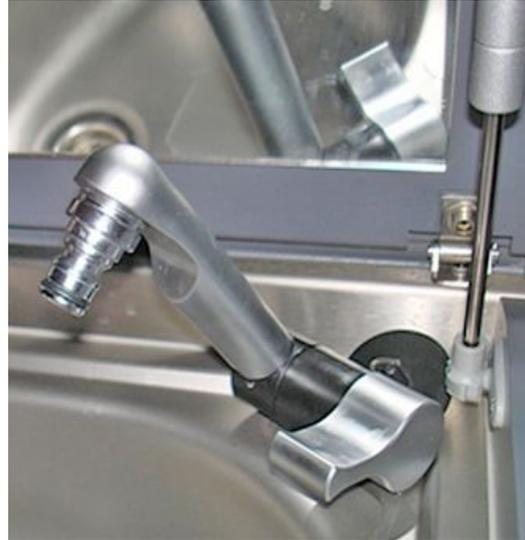
podemos construir con una *hembra* y, por ejemplo, **una pieza macho de 3/8" soldada con masilla**, la conexión para el flexo de ducha como se explica en otro *brico*.
