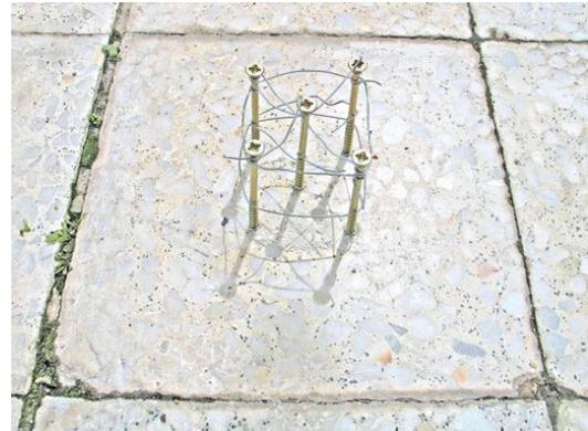
Recortamos seguidamente **cuatro piezas de 72 cm** de largo con las que agotaremos un tubo de PVC blanco de 110 mm  $\varnothing$  que, precisamente, se comercializa en tiras de 3 metros. Y antes de emplearlas, le atornillamos a las cuatro a unos diez centímetros de uno de los extremos **cuatro tornillos de rosca-chapa** asegurados por el lado interior con cuatro tacos iguales que los puestos en el suelo ( *Fischer* del 8 ).
