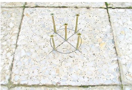
Con el fin de que todos ellos queden arriestrados y formen una malla compacta, los unimos con **alambre de encofrar**.
