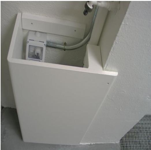
– Finalmente se lleva la tubería de desagüe hasta el colector más cercano
