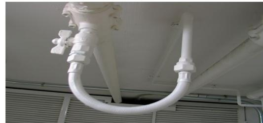
unir la tubería principal con nuestra derivación. Así en caso de reparación o mantenimiento podremos **cortar el suministro** a esta nueva sección sin necesidad de desoldar.
