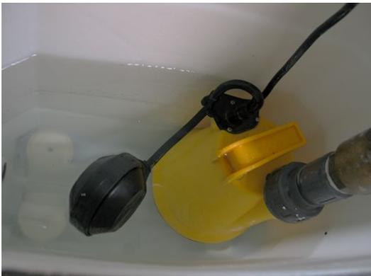
el flotador subirá y entrará automáticamente en funcionamiento, evacuando toda el agua hasta alcanzar el **nivel mínimo**. Entonces se detendrá sola.
