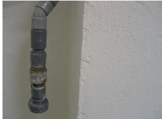
para que el agua de la parte vertical de la tubería de desagüe, una vez llena, no trate de **volver por gravedad** hacia el aparato. Así podremos desmontarla para limpieza o reparación sin que toda la columna de agua se nos caiga encima.
