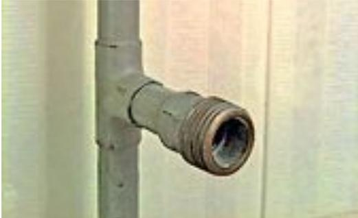
les **practicamos orificios de salida de aire** (de 2 mm  $\varnothing$ ) **separados 20 mm** y a las ramas más alejadas con un intervalo menor, **10 mm**.
