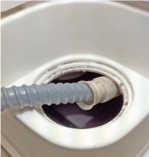
aseguradas ambas con abrazadera para que no se separen en el futuro con la fuerza de retroceso del agua impulsada, metemos todo el conjunto dentro del cassette por el bocal,
