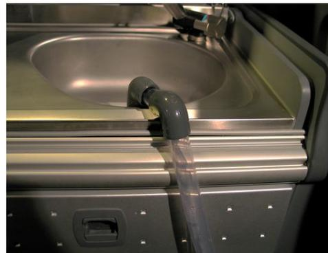
También se puede hacer con aquellos **arcos de plástico con forma de curva** que regalaban antiguamente cuando comprabas la lavadora para ajustar el tubo (de 30 mm  $\varnothing$ ) de salida de agua del aparato a un fregadero o pila de lavar. Mucha gente no tenía el tubo de desagüe en la pared y vaciaban el agua en un saneamiento. Hoy esto casi ha desaparecido, pero en algunos comercios de fontanería lo siguen vendiendo.
