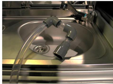
Finalmente, cuando pongamos la manguera al montar la ducha, encajamos el conjunto en el borde del fregadero mediante una **ligera presión**. Y ya no se mueve, por más fuerza que impela la bomba al agua. ¿No os ha pasado nunca que dejando una manguera de jardín abierta dentro de un cubo, al final se sale del cubo por la fuerza del agua como si fuese una serpiente que estuvies viva? Pues se trata de evitar eso y no poner *perdida la furgo*.
