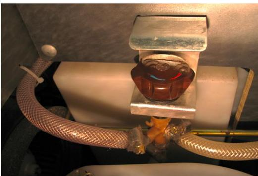
El aparato terminal, en este caso, sería la **válvula de retención** para poner y quitar rápidamente el flexo de ducha.
