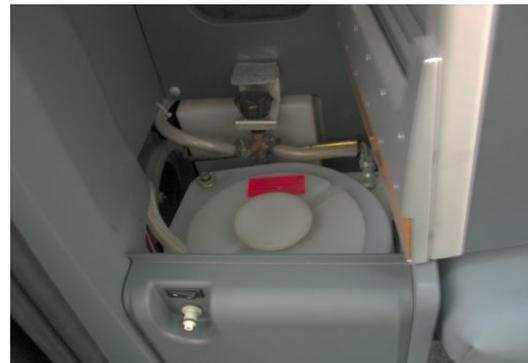
La espita del mezclador para **agua fría** se une con la tubería fría trasera en dirección al depósito; la espita de **salida de agua atemperada** con el fragmento que va a la válvula de retención; y la espita restante, la de **agua caliente**, la unimos con manguera hasta el lado libre de un racor en T que habremos instalado en cualquier punto del recorrido de la **tubería general de agua caliente** a partir de la salida del calentador.
