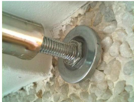
De esta forma, podremos poner tornillos regulables en los extremos acabados en arandela fijada con soldadura en frío y **apretar la barra cómodamente contra las paredes** sobre una pequeña pieza de madera pintada con la forma de nuestros revestimientos.
