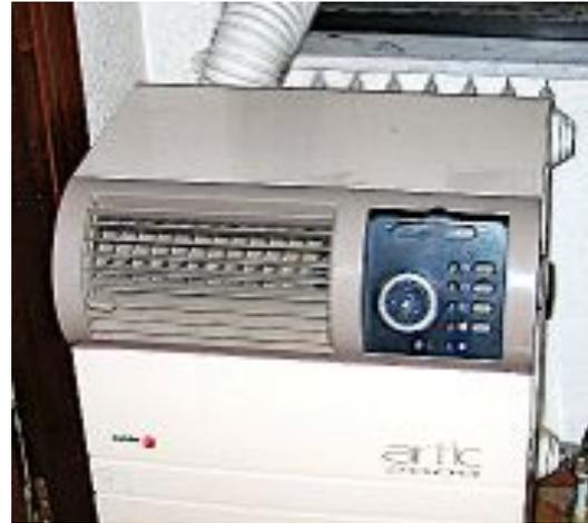
ya empieza a dar problemas con el sistema de **evacuación de agua de condensación**. Y no hemos podido localizar el punto donde **falla el mecanismo que lleva a la bandeja ese agua** para que se vaya acumulando.
