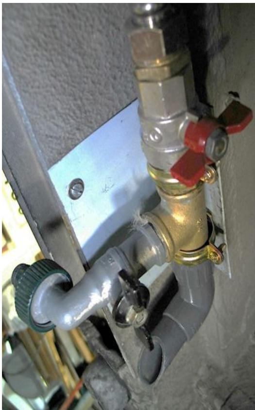
Luego, empleando los codos necesarios, nos vamos dirigiendo hacia el depósito **anclando el tubo flexible a la viga horizontal** de los bajos mediante abrazaderas.
