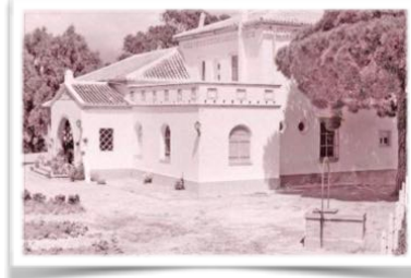
5042 La hostería ampliada ca. 1952 . En primer término el pozo que aún se evoca en el edificio actual.
