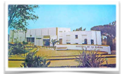
5041 Lupiáñez reconcibió un edificio de estética funcional con volúmenes adaptados al desnivel del terreno.
