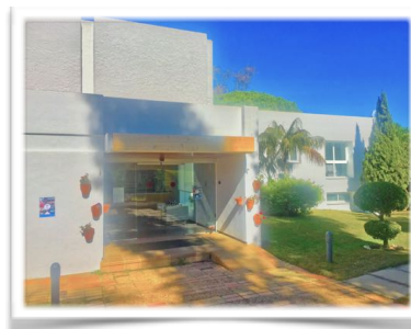
1001 Entrada principal en febrero de 2019
