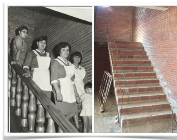
5015 y 1001 La balastrada torneada en servicio y tristemente perdida en 2016
