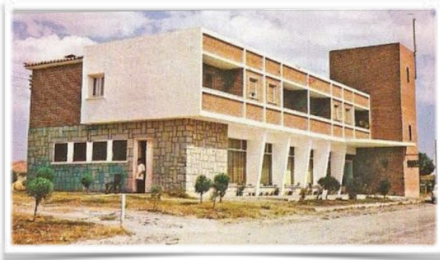
5016 Exterior del parador recién terminado
