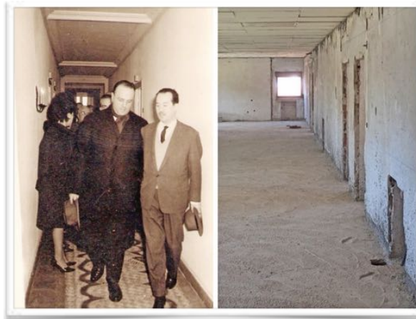
5015 y 1001 El mismo pasillo de habitaciones de la planta superior visitado por Fraga en 1964 y desfigurado en 2016
