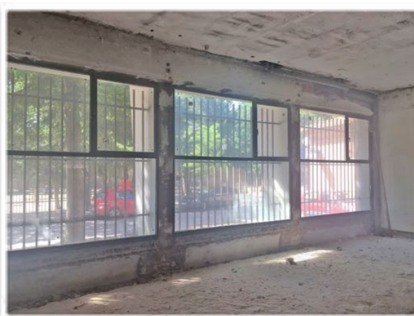
1001 En junio de 2016 esto queda de aquel magnífico comedor
