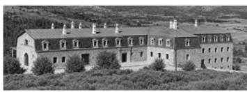
4002 La II ampliación desde la ladera noreste en 1945 .
