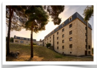
1001 La ampliación occidental de Sainz de Vicuña juega con el enorme desnivel de la ladera. Imagen de julio de 2026.
