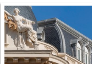
6052 Detalles actuales de las cubiertas abuhardilladas del hotel Palace de Madrid.
