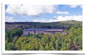
9031 Desde el sur, ya en abril de 2023 , este vuelo da una panorámica completa de la III ampliación .
