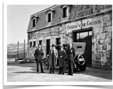
5159 Clientes posando en la fachada norte ca. 1929 .
