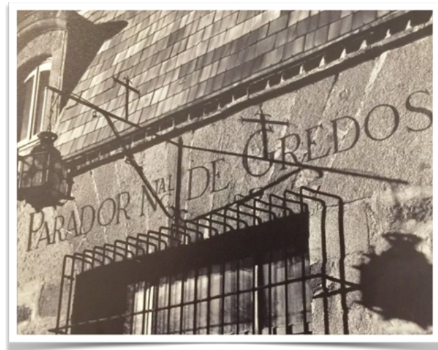
8503 Detalle del rótulo de la fachada norte del parador.
