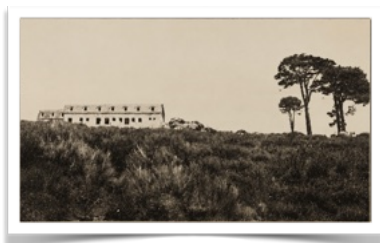
3034 Aspecto en 1927 del avance de las obras vistas desde el lado sur.
