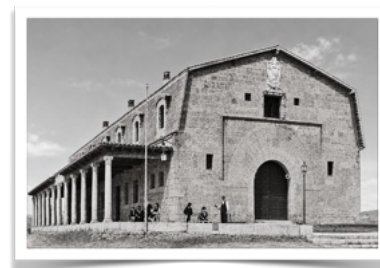
4001 Recién añadido el voladizo a la construcción, en 1928.
