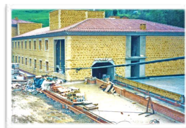
4016 Última fase de las obras del anexo
