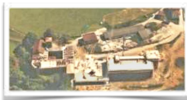
2007 Avance de la obra en 1997 desde el oeste
