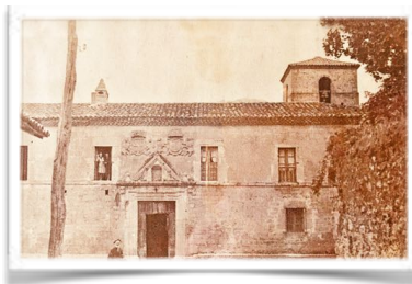
4016 Instantánea de 1945 de la fachada meridional con edificaciones anexas
