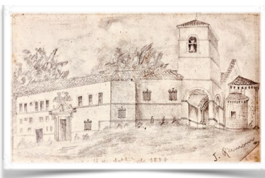
4016 Dibujo de J. Ramom con la fachada sureste del convento el 14 de septiembre de 1888
