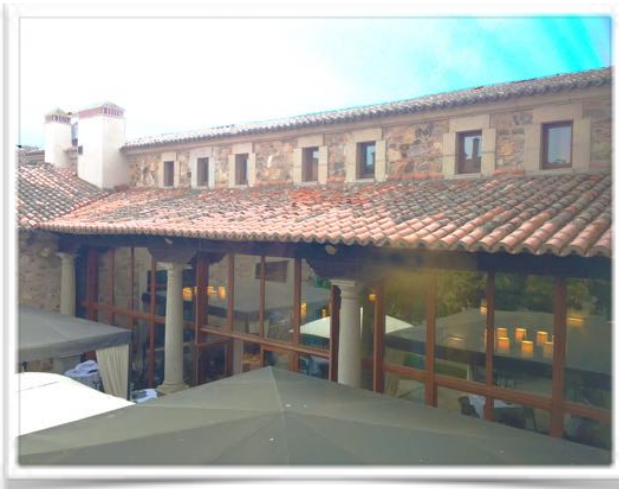
1001 El pabellón de caballerizas acoge hoy al restaurante Torreorgaz y, sobre él, seis habitaciones (210 a 215) que hasta 1984 fueron alojamiento de empleados de la hostería.
