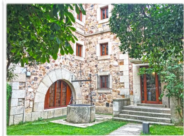
1001 La entrada por el pozo a la antigua hostería no era practicable para los clientes. Aspecto en agosto de 2017.
