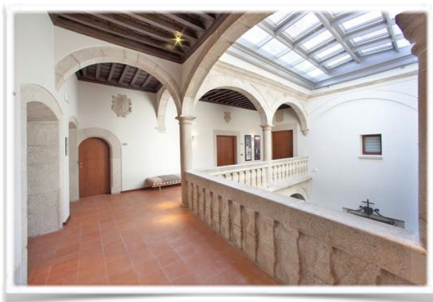
6001 Las habitaciones 201 a 203 de la planta noble proceden de la compartimentación terminada en febrero de 1991 de tres salones de reuniones
