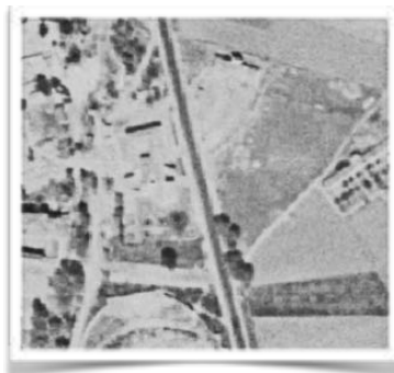
1056 Vista aérea de 1956 hecha por el ejército de EE.UU. con las primeras construcciones del ala Este y el patio de la ampliación en obras
