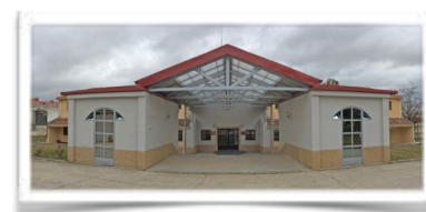
1001 La nueva tejavana de entrada a la comisaría une y embellece dos de los antiguos garajes cerrados del albergue
